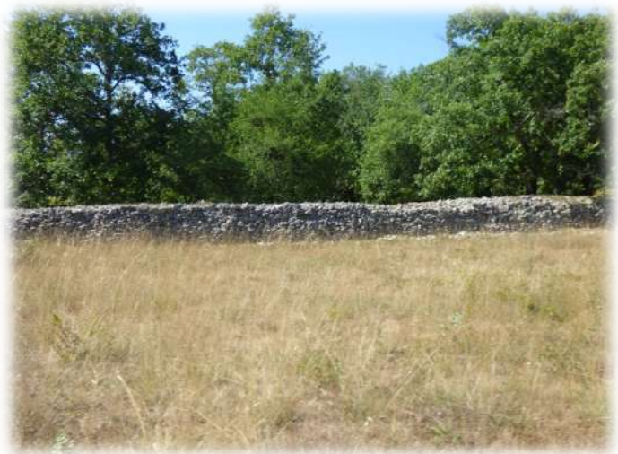
Photo 6 : Muret en pierres sèches (CCPLL), © RC ; 2019
