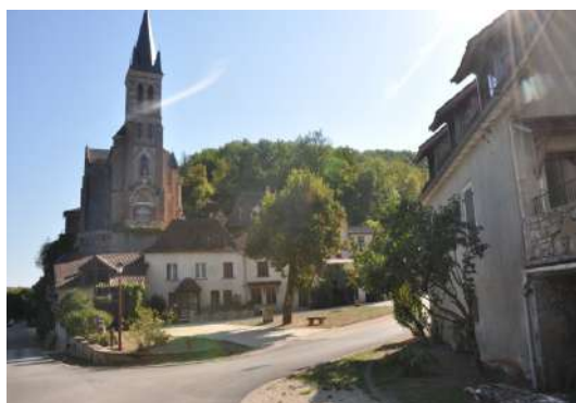
Place à Crégols avec son église implantée sur la roche
