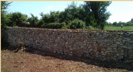
Mur de soutènement
