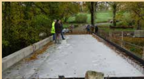
Pont de Lartigue
