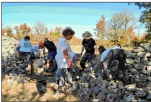
Une équipe sur un chantier à Escamps - Crédits : JLM46
