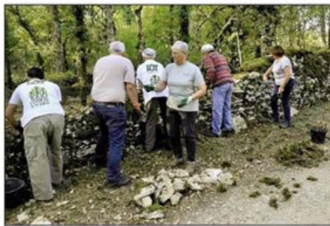
Un chantier sur Limpogne - Crédits : JLM46
