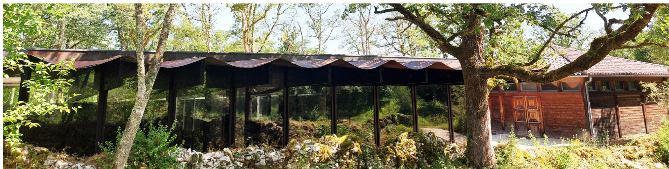
L'intégration paysagère du bâtiment a été prépondérante.
