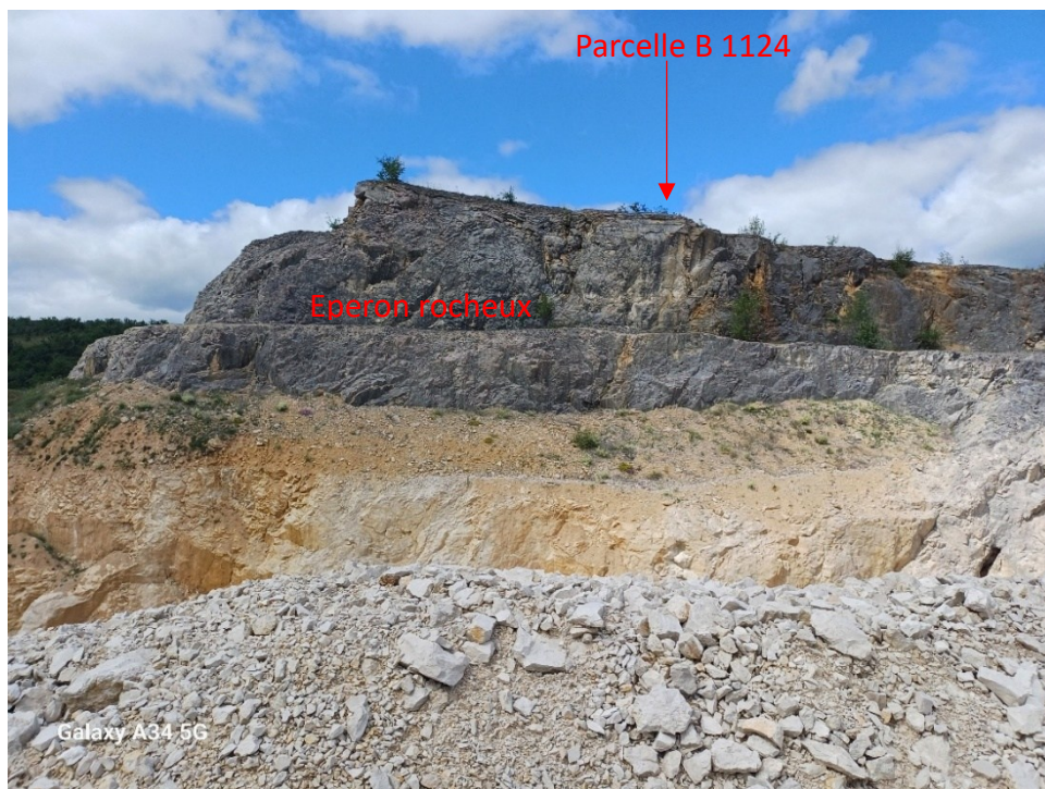
Vue sur le front nord-est en limite de la parcelle B 1124, depuis la piste située en face (Arca2e, NL, le 26 mai 2025)
